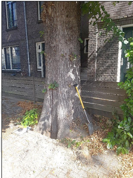
De bestrating is tot aan de stamvoet aangebracht
