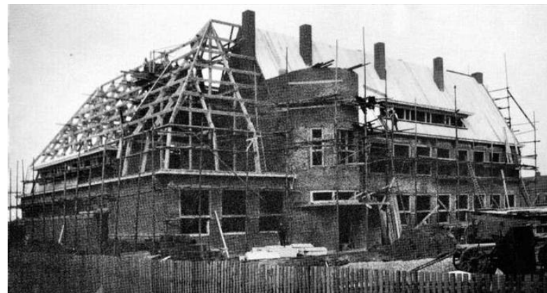
afb. 77 De Elbertschool aan de Lijnbaan in aanbouw, 1930 (coll. NAI, Rotterdam).
