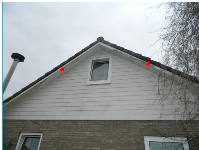
Foto's: Geschikte openingen voor vleermuizen om bij een verblijfplaats te komen.
