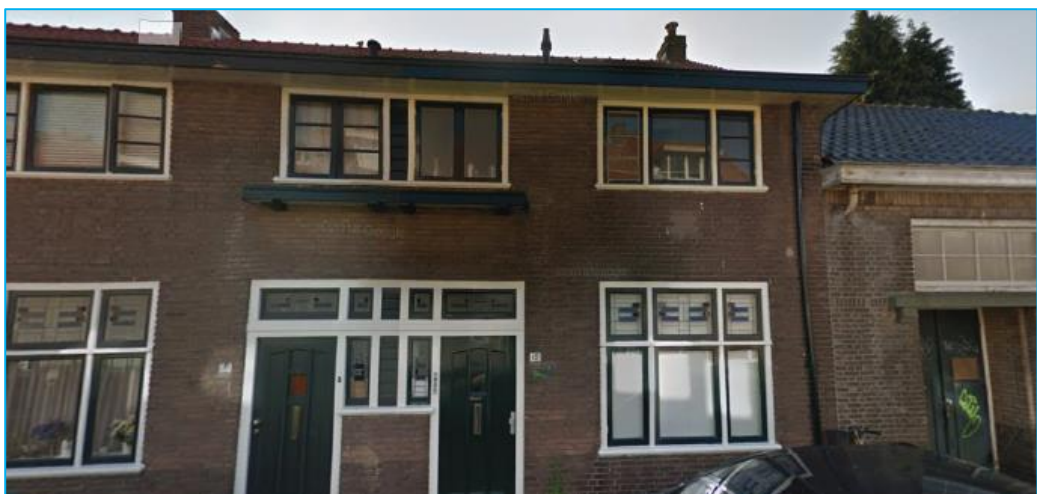
raampartij gebaseerd op bestaande ramen omgeving en schoolgebouw
