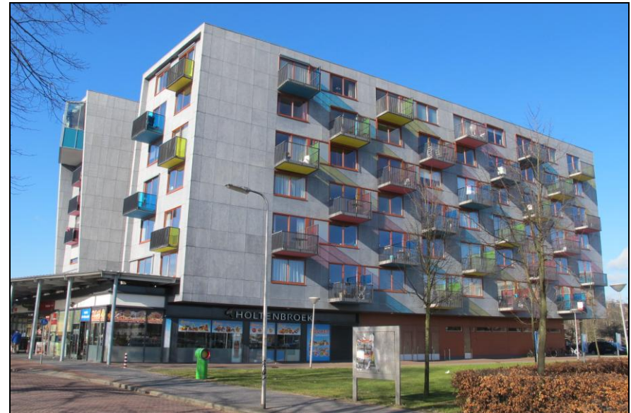
afb. 64 Modern vormgegeven woonflats langs het gerenoveerde en grotendeels nieuw opgezette winkelcentrum aan het Bachplein.
