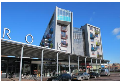
afb. 58 & 59 Recentelijk gerenoveerd en vernieuwd wijkwinkelcentrum Holtenbroek, als hart van de wijk.
