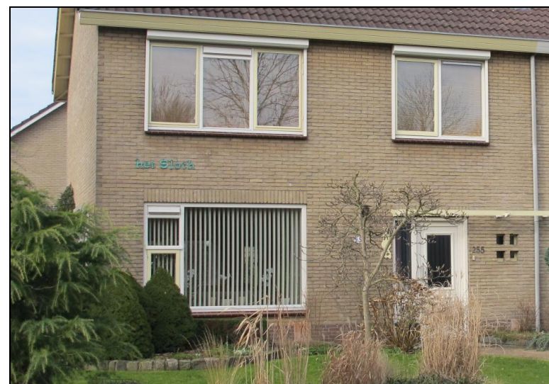
afb. 42 Middelweg 255 op de hoek van de Gombertstraat draagt de naam Het Sloth. Het pand staat niet ver van de locatie van het gelijknamige verdwenen huis.
