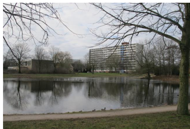
afb. 54 & 55 De langs het assenkruis gelegen groenstroken vormen een belangrijke groene long, gecombineerd met schilderachtige waterpartijen.
