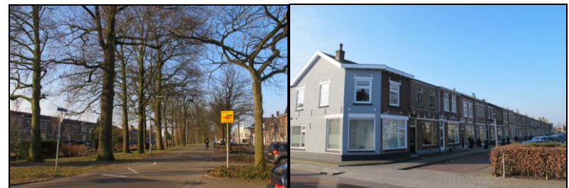
afb. 18 en 19 Links de Schellerallee, rechts de Van Laersweg.
