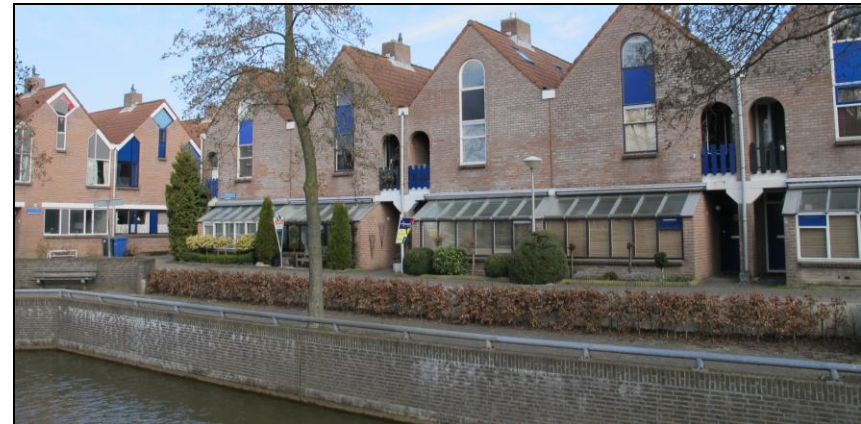
afb. 48 en 49 Bovenaan de De Savornin-Lohmanstraat in de Staatsliedenbuurt. Onderaan de Munterkamp in de Gerenlanden. Deze grachtenpanden uit 1978-1980 zijn ontworpen door G.J. van den Belt.
