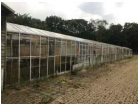
Kassen met asbest
