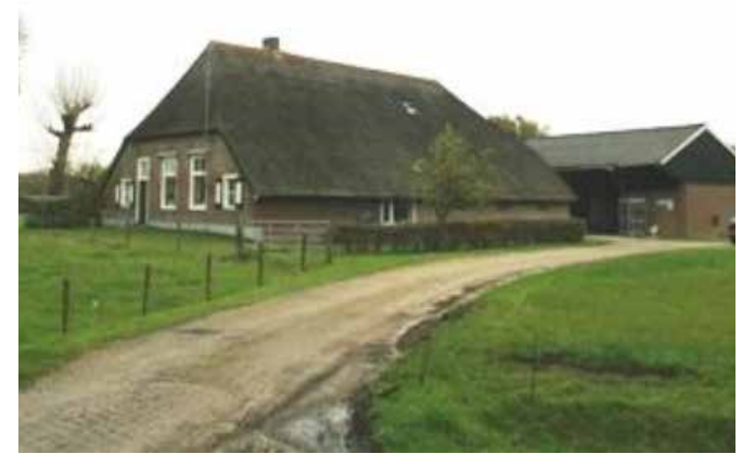
De bestaande monumentale boerderij blijft behouden
