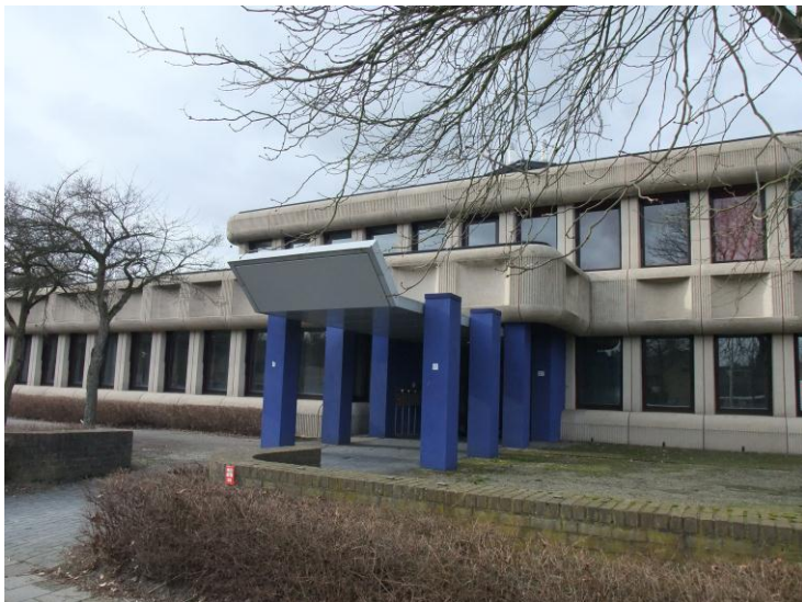
afb. 14 Zwarte Waterallee 25: opvallend kantoorgebouw met plastisch vormgegeven gevels met betonelementen.
