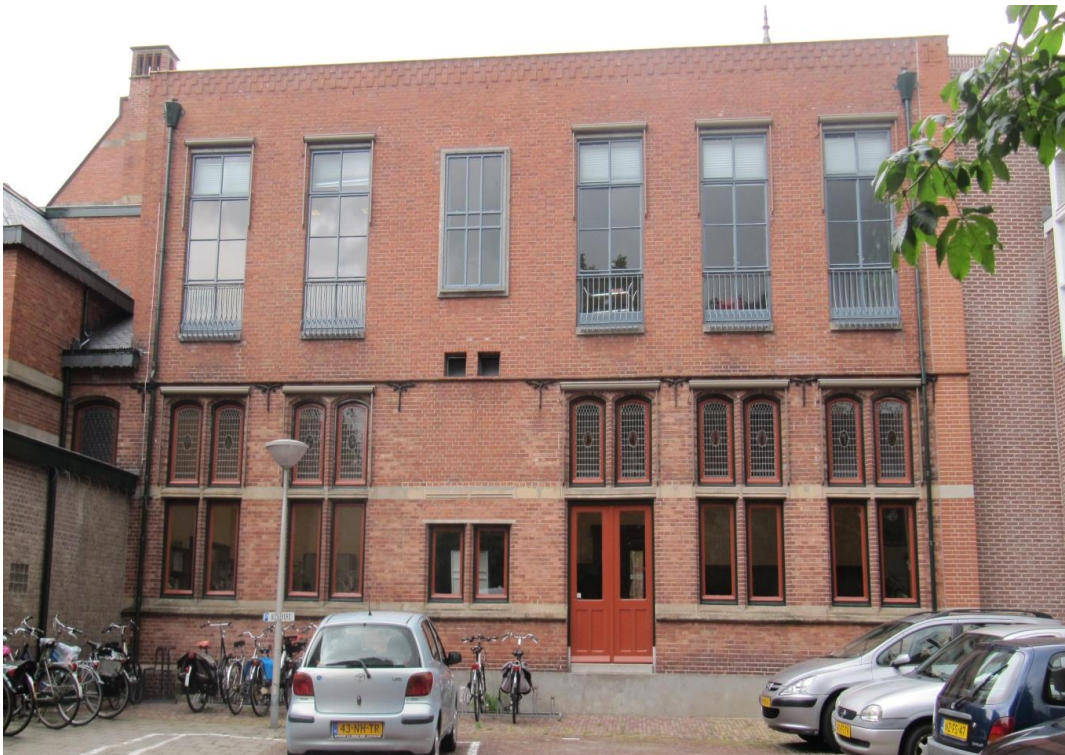
Gevel van de Commissaris des Konings vleugel aan de binnenhof zijde. De bouwsporen van de ophoging en het linker muurdeel is duidelijk te zien
