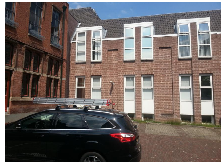
Nieuwe achteraanbouw achter het Gouvernementsgebouw
