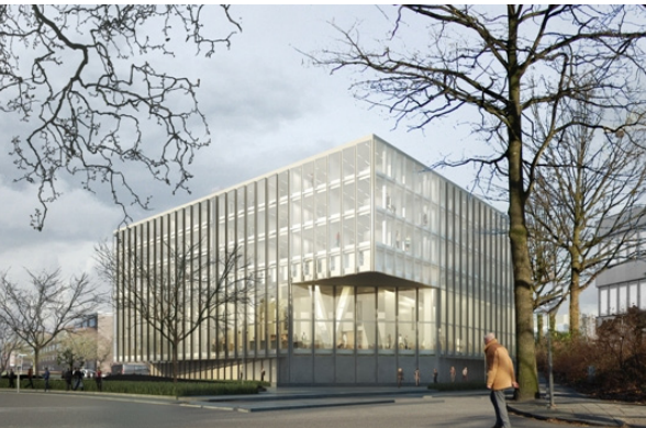
Nieuwbouw Rechtbank Zwolle
