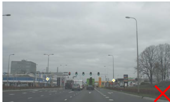
zichtpunt 10: kruising Ceintuurbaan - Boerendanserdijk
