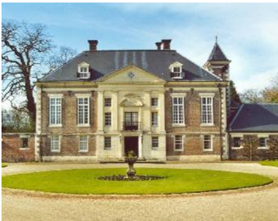
Afb. 24 Diepenheim. Oorspronkelijk was er sprake van een hoge stoep (als bij Zandhoven, in de afbeelding hiernaast). In 1707 is de entree verbouwd.
