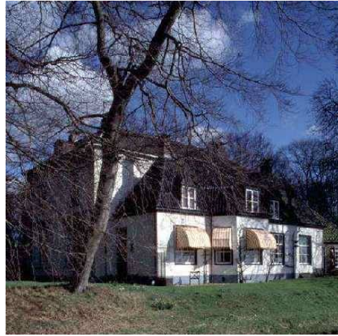
Afb. 23 De oude spijker tegen de achtergevel van de uit 1840 daterende buitenplaats Colckhof.
