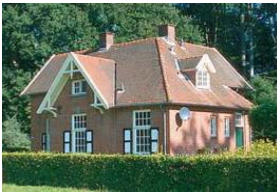
Afb. 64 Tuinmanswoning op landgoed Twickel (elementen van Chaletstijl).
