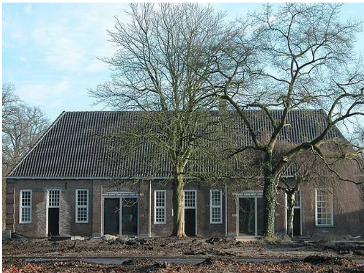
Afb. 43 Bouwhuis van voormalige havezate Kranenburg bij Berkum.
