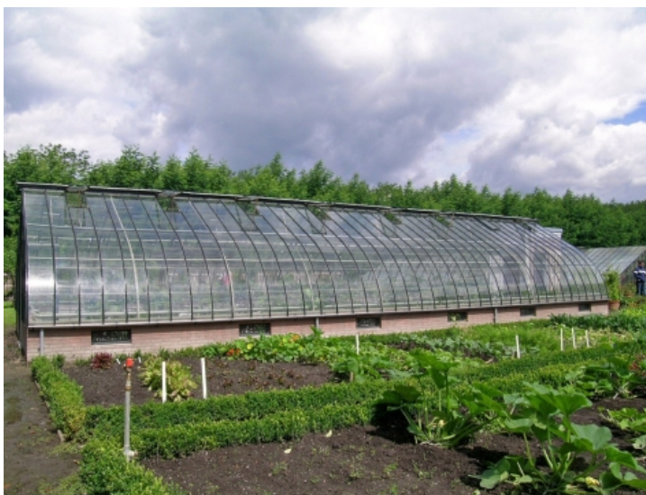
Afb. 58 Vrijstaande druivenkas bij buitenplaats Herteveld te Maarssen. In 1992 gebouwde kas naar voorbeeld van het oorspronkelijk uit 1845 daterende exemplaar.
