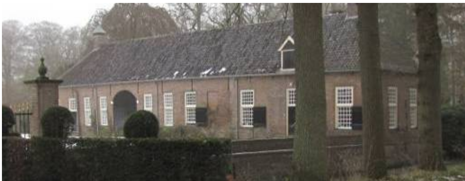
Afb. 37 De bouwhuizen van Den Berg.
