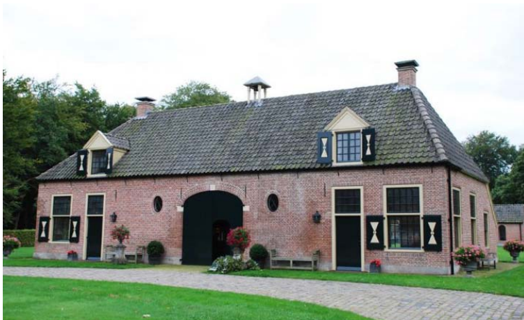
Afb. 39 Bouwhuis van havezate Alerdinck. Bij Alerdinck is maar één bouwhuis aanwezig.
