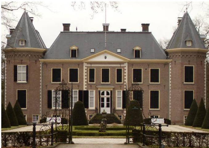
Afb. 27 Het Nijenhuis te Diepenheim. Dit gebouw is toegeschreven aan Vingboons. De twee hoektorens zijn in de negentiende eeuw toegevoegd.
