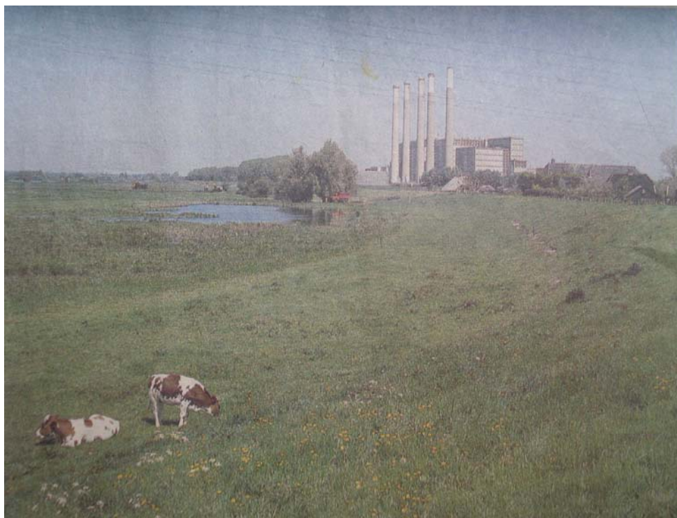
Afb. 58 De IJsselcentrale, voordat twee van de vier schoorstenen zijn afgebroken.
