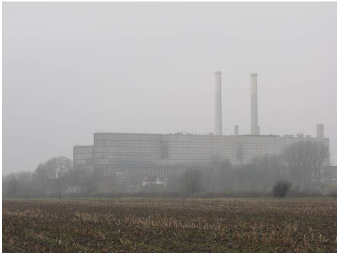
Afb. 54 De IJsselcentrale, gezien vanaf de es.
