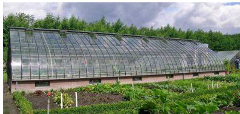
Afb. 82 Vrijstaande druivenkas bij buitenplaats Herteveld te Maarssen. In 1992 gebouwde kas naar voorbeeld van het oorspronkelijk uit 1845 daterende exemplaar.
