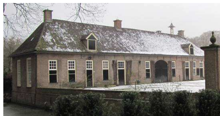
Afb. 64 Bouwhuis van Den Berg.
