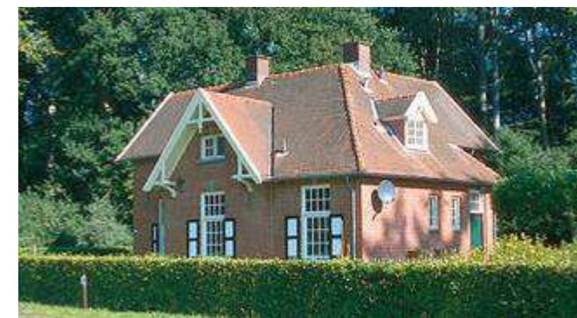
Afb. 68 Tuinmanswoning op landgoed Twickel (elementen van chaletstijl).
