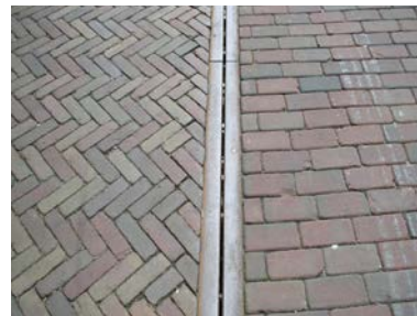
Hemelwater Zorgvuldig ontworpen hemelwaterafvoer
