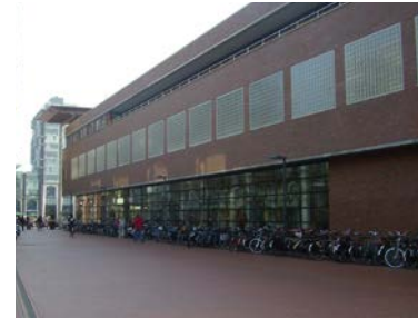
Stallingsruimte Plaatsingsruimte voor losgeplaatste fietsen
