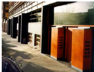
Entree Stijlpunten zijn geïntegreerd in de gevel
