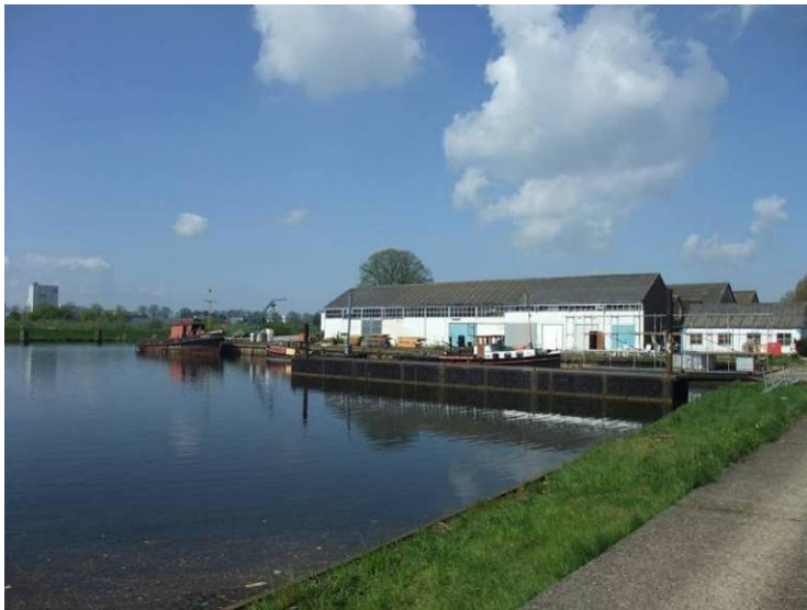
afb. 85 en afb. 86 Het Zwarte Water in april 2010.
