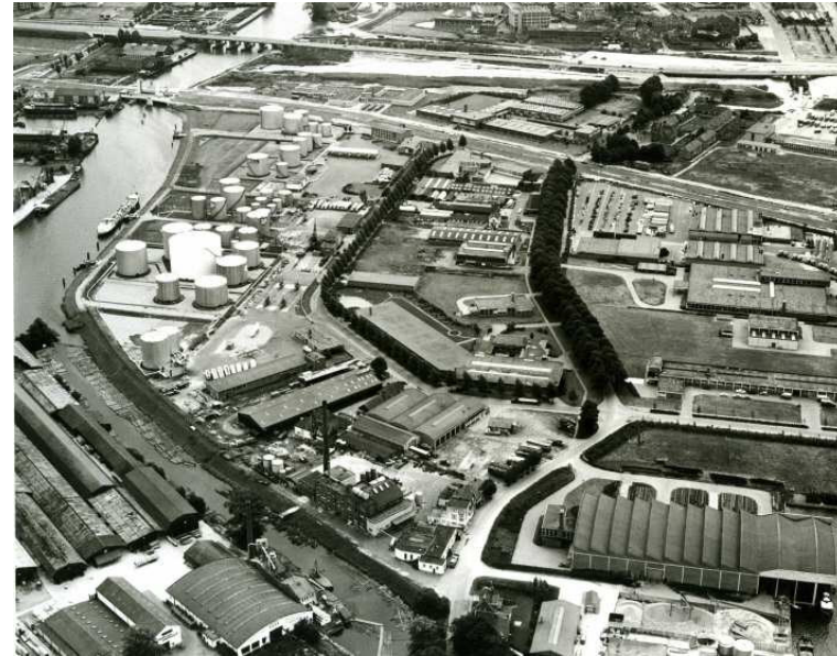
afb. 80 Luchtfoto 1963 (HCL FD028.287), Voorst A gezien naar het westen, met links boven het Zwarte Water, links beneden houthandel Stiho aan de Riete.
