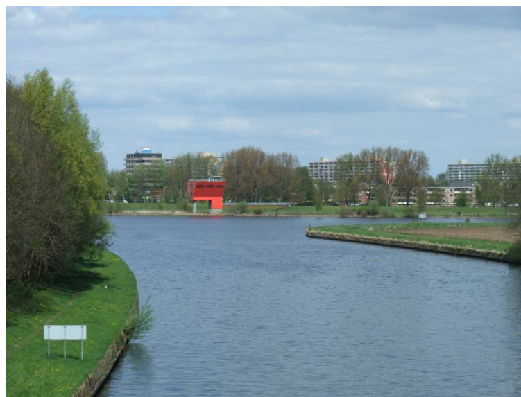
afb. 5 en afb. 6 Het Zwarte Water bij de aansluiting van het Zwolle-IJsselkanaal.
