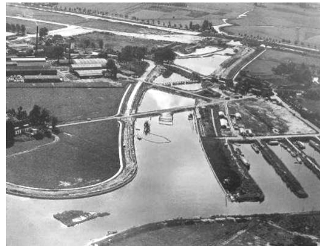
afb. 79 Luchtfoto van de aanleg van het Zwolle-IJsselkanaal, zicht in zuidwaartse richting, ca.1962. Rechts van het kanaal ligt achter de haven het huidige gehucht Frankhuis. Links het voormalige buiten Zorgvliet met erachter de houthagerij. Op de achtergrond is bij de spoorlijn goed zichtbaar hoe het kanaal door het oude riviertje heen wordt gegraven (HCO).
