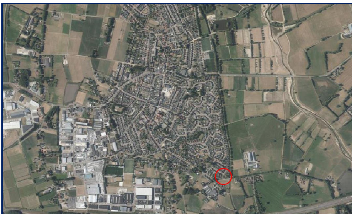
Figuur 1.1: projectlocatie Zuiderstraat 45 Enter (bron: PDOK; bewerking Ad Fontem)
