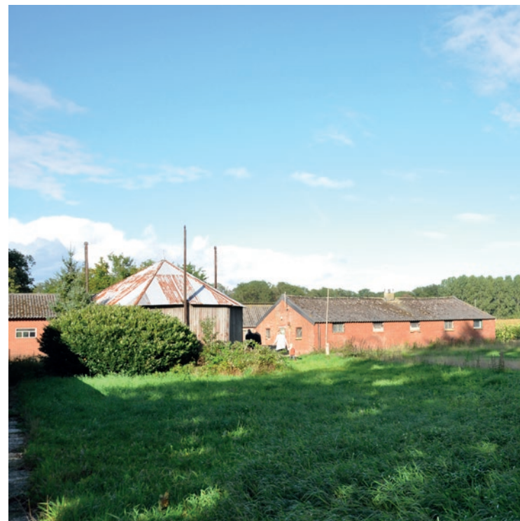
Achtererf met zicht op de te slopen landschapsontsierende bebouwing
