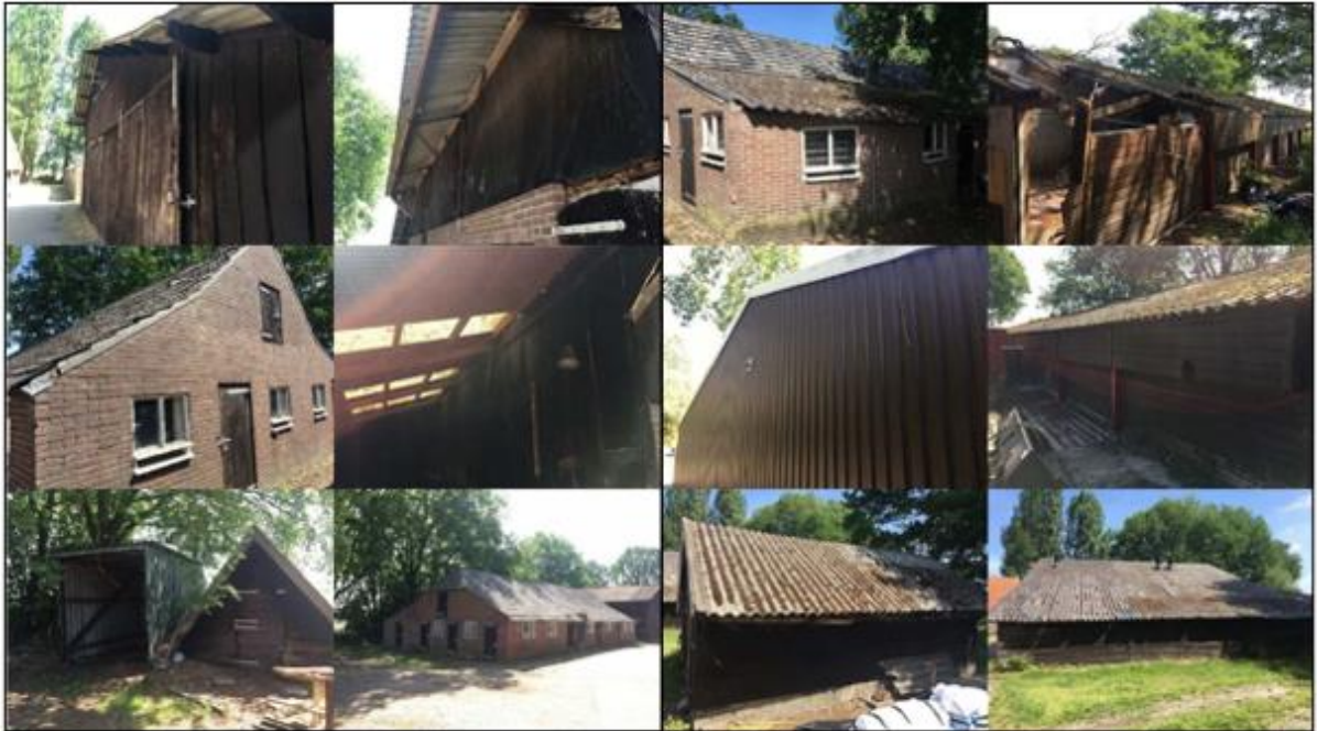
Figuur 2.3 Foto's te slopen bebouwing (Bron: De Erfontwikkelaar)
