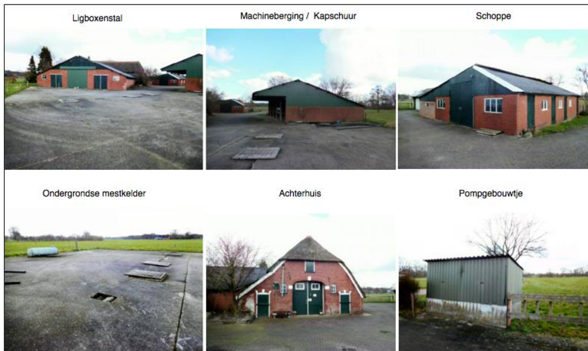
Figuur 2.2 Foto's huidige situatie (Bron: Kuiphuis vastgoed & advies)
