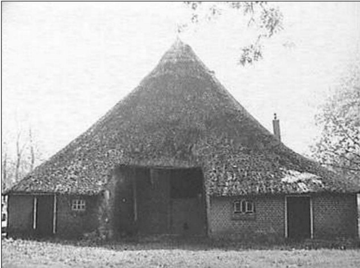
Figuur 4.3 Boerderij onder met stro en pannen gedekt dak in Zuna (Bron: H. Hagens)
