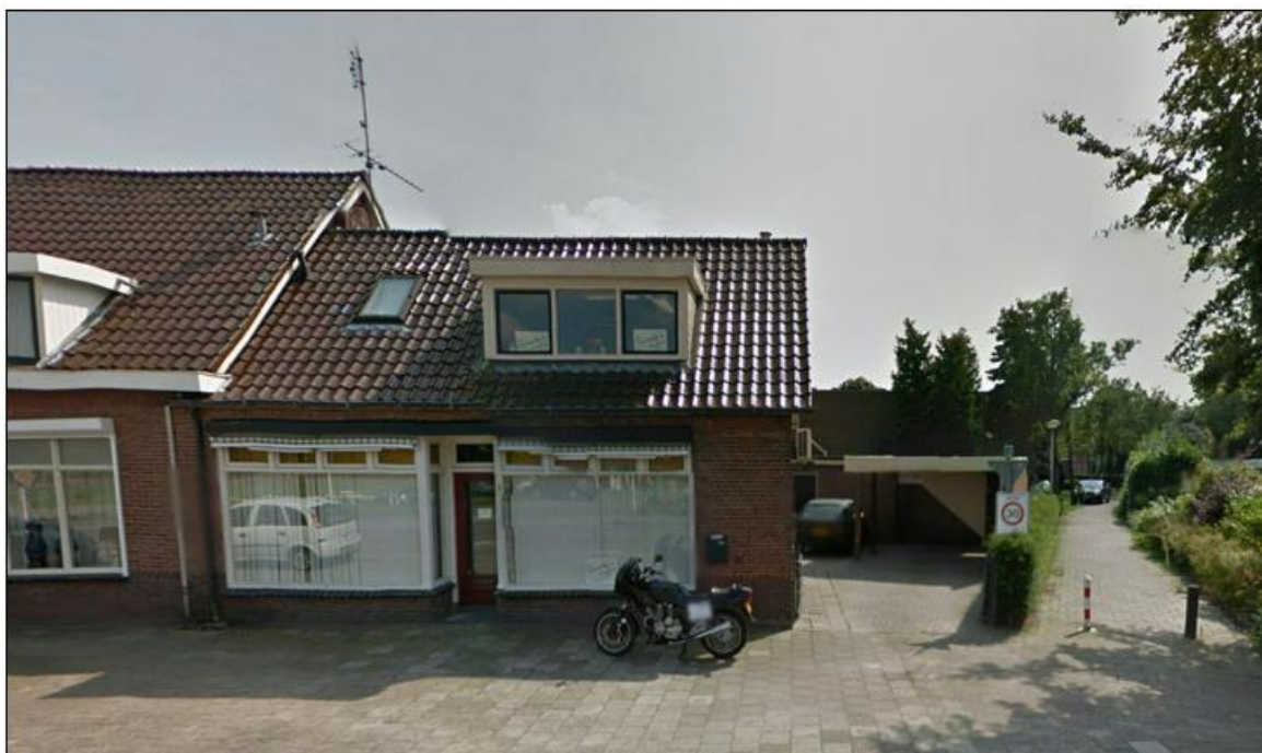
Afbeelding 2.3 Straatbeeld plangebied vanaf de Nijverdalsestraat (Bron: Google Streetview)
