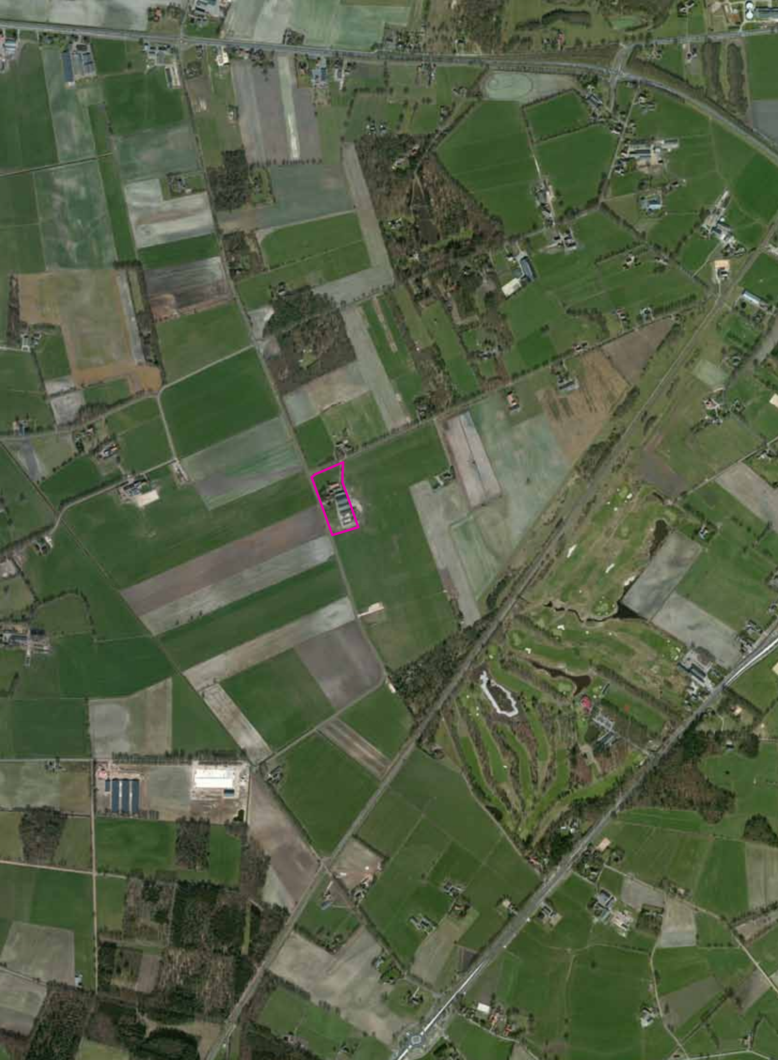
Afbeelding 21. Luchtfoto huidige situatie
