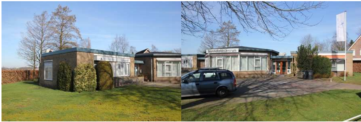
Foto's van het te slopen gebouw.
