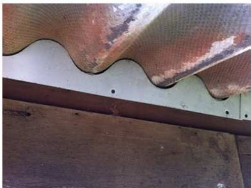
Afdichten van potentiële openingen voor steenmarters om de holle ruimte tussen golfplaat en dakisolatie te betreden in deelgebied Burgemeestersdijk.
