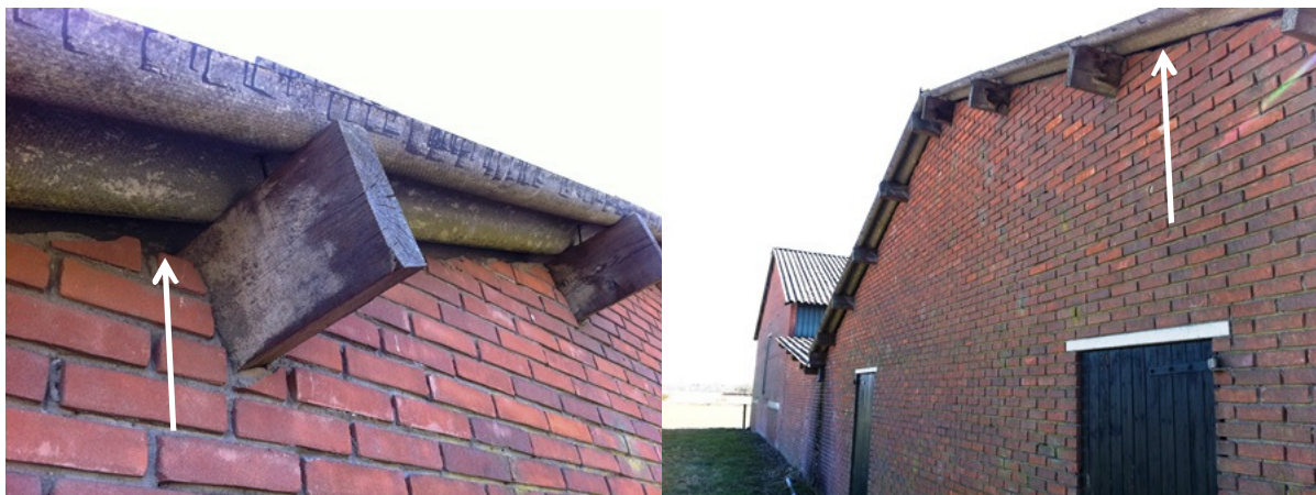
Potentieel geschikte verblijfplaatsen voor kleine- en grotere soorten. Met de pijlen worden de kieren aangeduid welke toegang verschaffen tot de spouwmuur.
