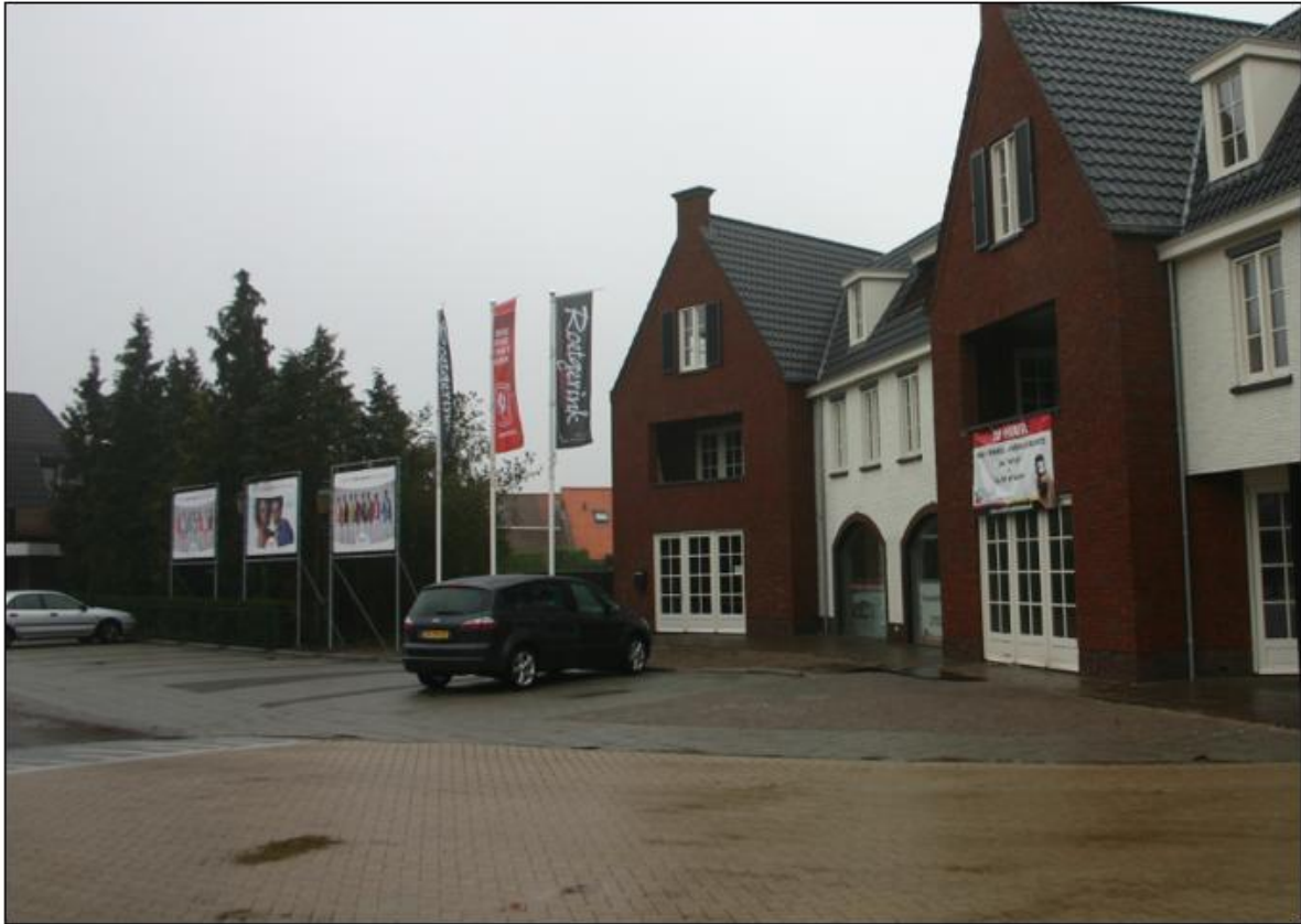
Afbeelding 2.3 Foto beoogde locatie buitenterras en op achtergrond locatie parkeerterrein
