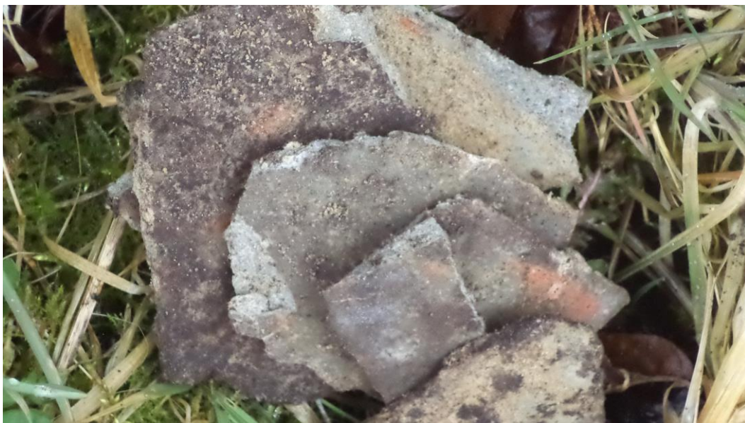
Foto 4: stukjes asbesthoudend materiaal (M2) uit sleuf S4
