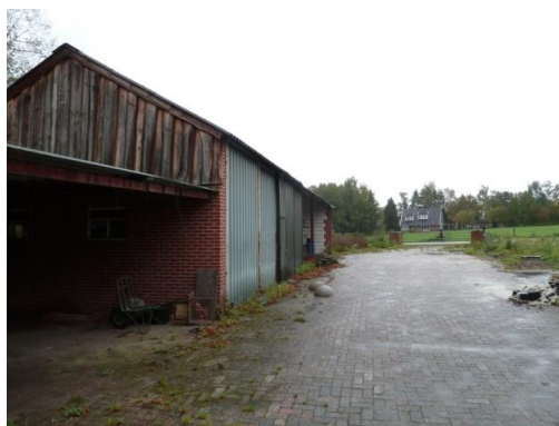
Afbeelding 3: werktuigstalling met werkplaats
