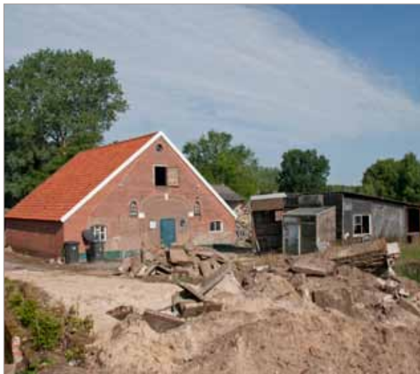
Afbeelding 20. Zicht op het huidige erf
