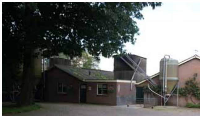
de entree van de varkenstallen
