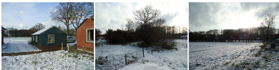
Foto's: Overige te slopen opstallen en omgeving.
