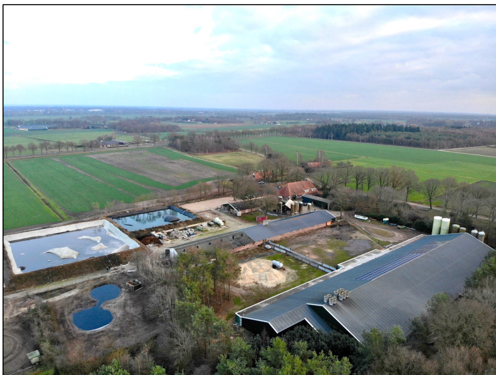
Afbeelding 2.1 Het bedrijf van Maatschap Hoff vanuit noordwestelijke richting
