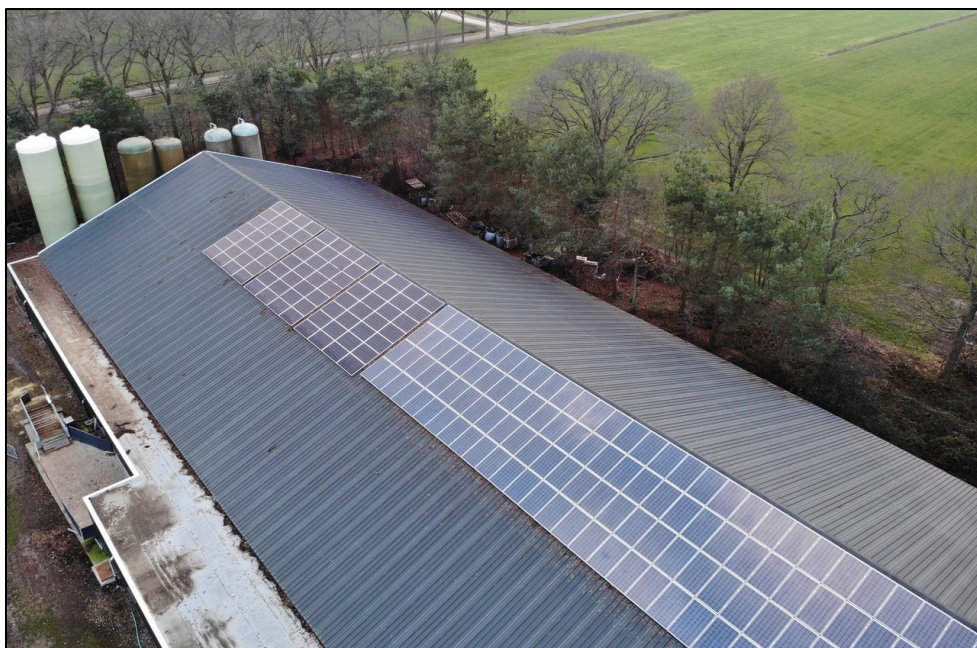
Afbeelding 2.3 Zonnepanelen op de varkensstal
