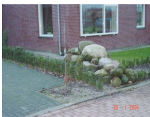
figuur 4.7 voorbeelden van afkoppeling HWA bij woningen
