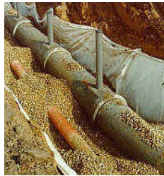
figuur 4.6 infiltratieriool (permeobuis)
