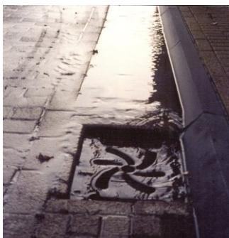
figuur 4.3 waaier kolkkop
