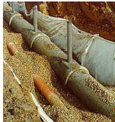
figuur 4.6 infiltratieriool (permeobuis)
