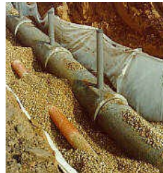
figuur 4.6 infiltratieriool (permeobuis)
