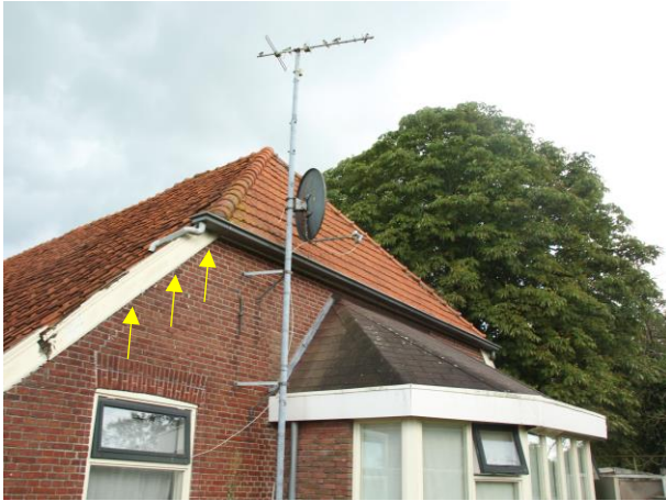
De daklijsten sluiten strak aan op de buitengevels (gele pijlen).
