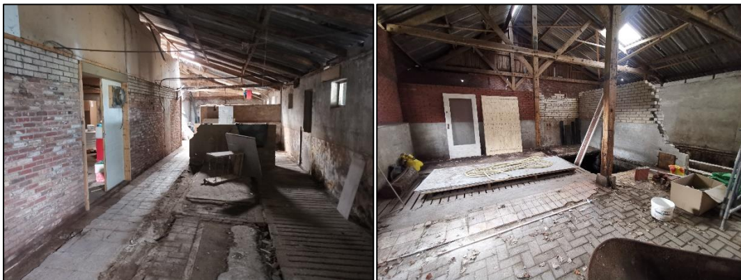
Figuur 2.4: Binnenaanzicht van de te slopen bebouwing.
