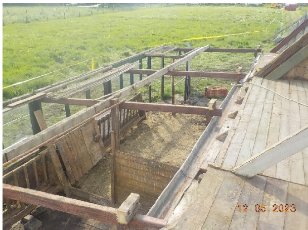
7. Locatie verwijderd asbest
