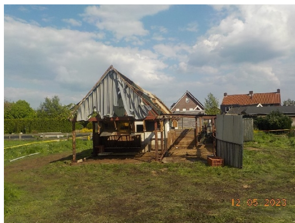
4. Locatie verwijderd asbest
