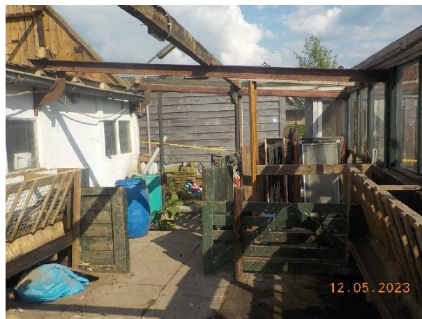
6. Locatie verwijderd asbest
