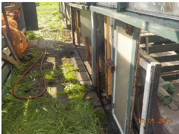
5. Locatie verwijderd asbest
