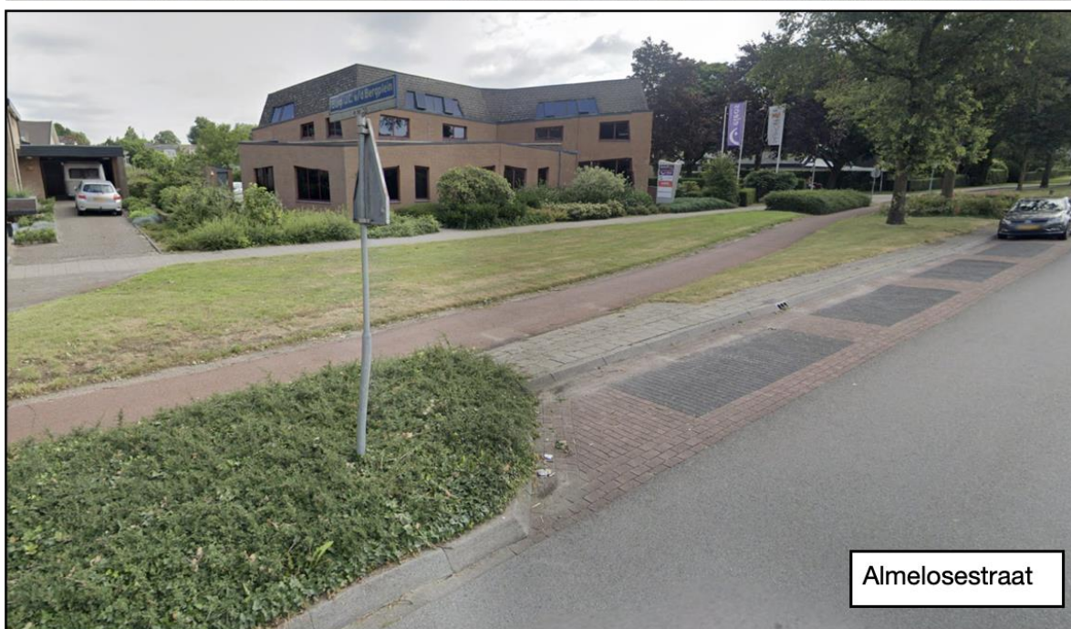
Afbeelding 2.2 Straatbeelden vanaf de Violierstraat en Almelostraat (Bron: Google Streetview)
