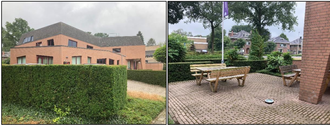
Figuur 2.3 (links): Een blik op het noordoosten van het plangebied, met vooraan een haag en daarachter de bebouwing; Figuur 2.4 (rechts): Een picknickplek op de zuidoosthoek van het plangebied. Het groen op de achtergrond hoort nog bij het perceel.
