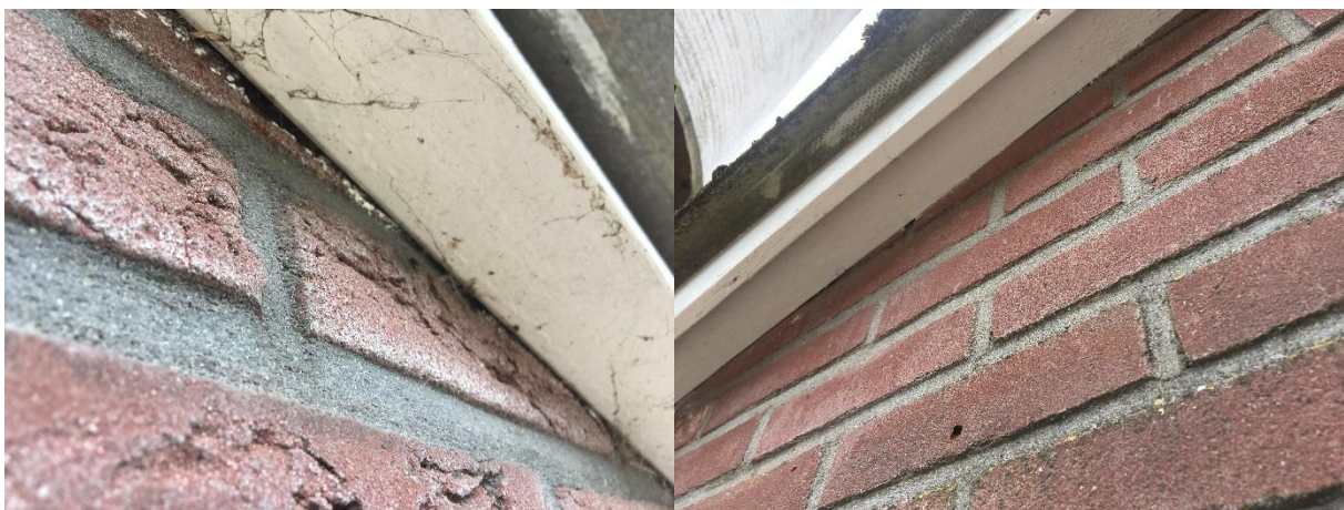
De betimmering van het dakoverstek sluit naadloos aan op de buitengevels.
