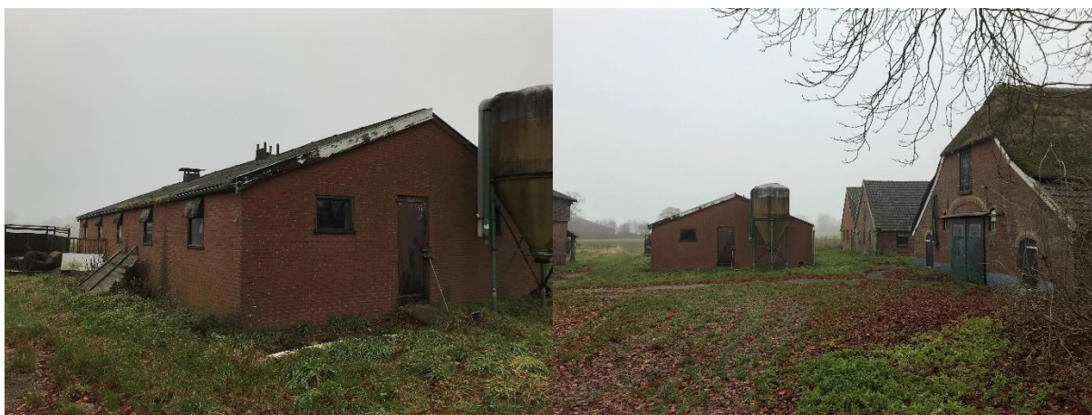
Afbeelding 6. De westelijke te slopen schuur (links) en een aanzicht van het gehele erf, gezien vanaf de Schapendijk (rechts).
