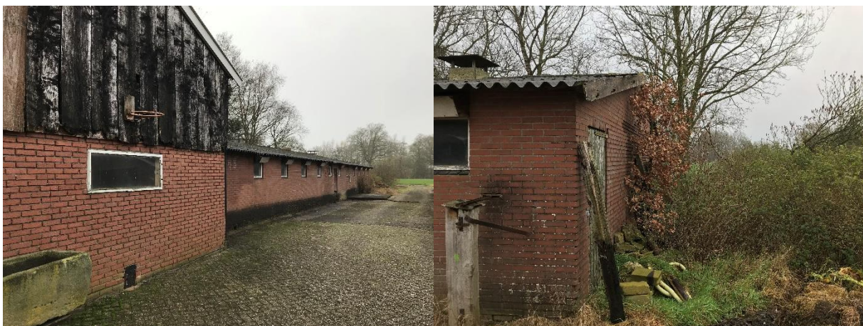
Afbeelding 3. Zicht op het erf, de westelijke schuur en de aangrenzende stal en werktuigenstalling (links) en het aangrenzende groen achter en ten westen van de westelijke schuur (rechts).
