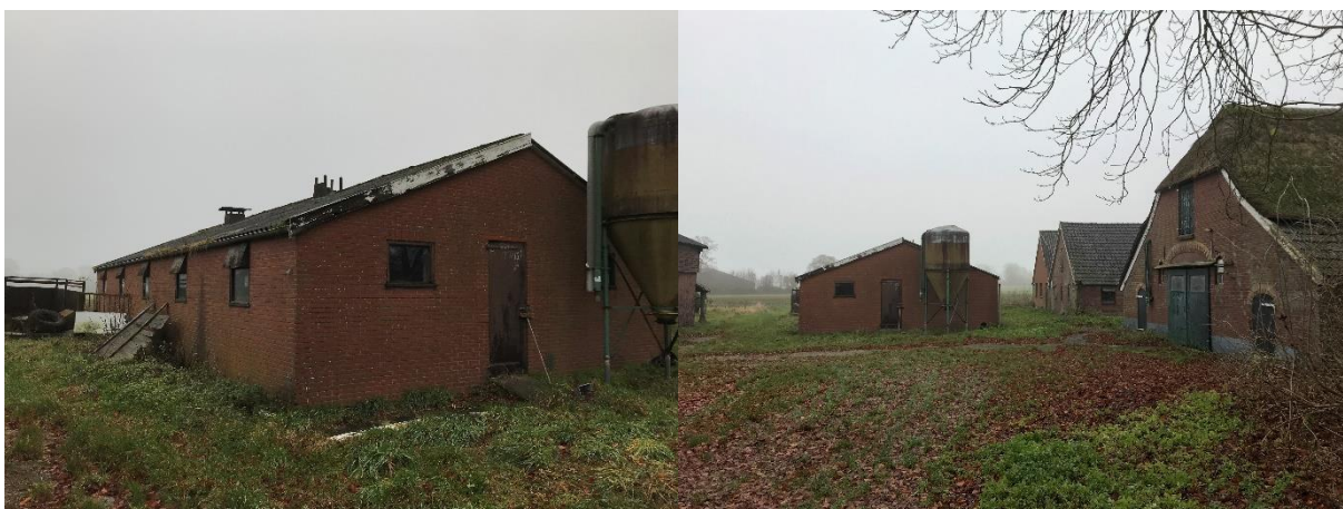
Afbeelding 9. De westelijke te slopen schuur (links) en een aanzicht van het gehele erf, gezien vanaf de Schapendijk (rechts).
