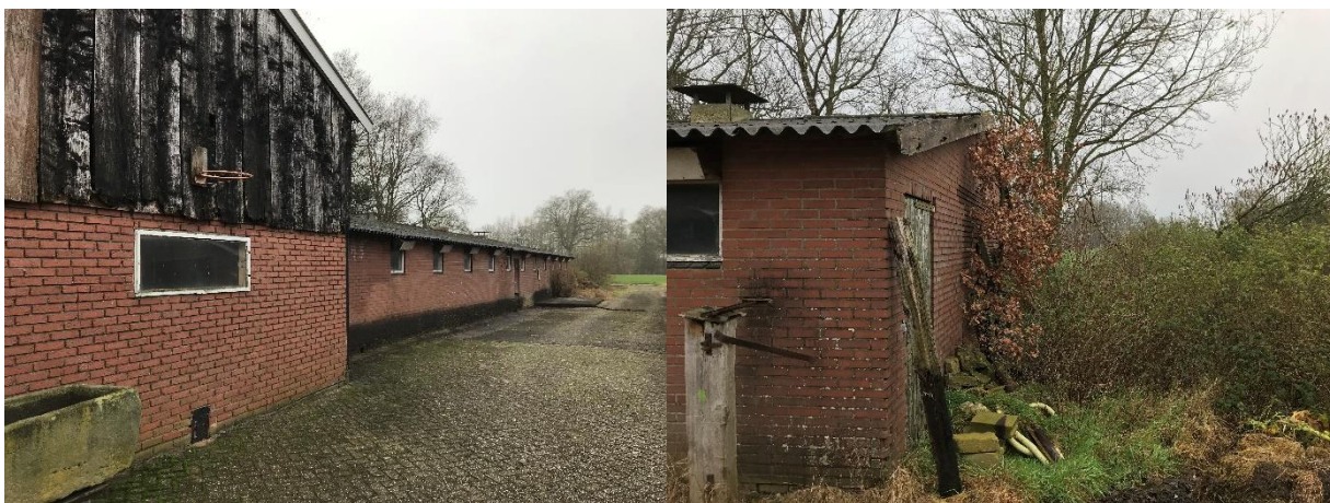
Afbeelding 6. Zicht op het erf, de westelijke schuur en de aangrenzende stal en werktuigenstalling (links) en het aangrenzende groen achter en ten westen van de westelijke schuur (rechts).
