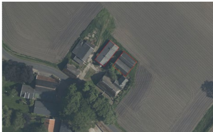
Afbeelding 4. Slooplocatie Schapendijk 37 met te slopen schuren binnen rode kaders.
