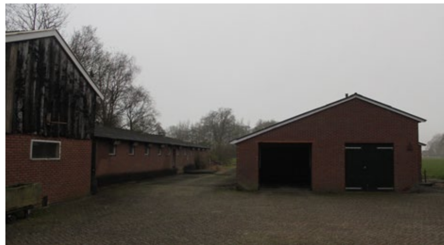
Afbeelding 18. De te slopen schuren op het erf aan de Sluizendijk 1.
