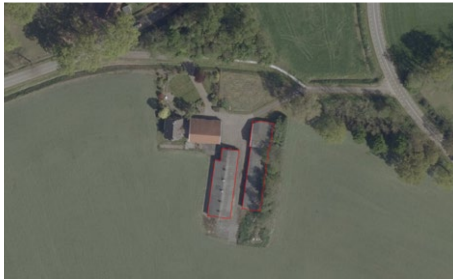
Afbeelding 3. Slooplocatie Sluizendijk 1 met te slopen schuren binnen rode kaders.
