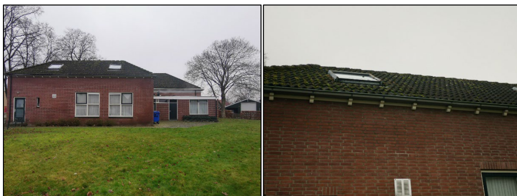
Figuur 2.5 en 2.6: Noordoostelijk aanzicht(links) en impressie van daklijst.
