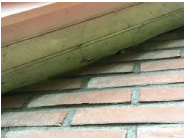
De betimmering van de overstek, sluit nauw aan op de gemetselde buitengevels van de garage.
