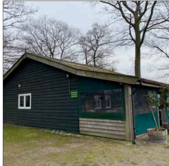
het bestaande gebouw
