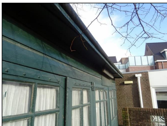
Figuur 11. dakbedekking van een van de bijgebouwen, waar geen toegankelijke ruimtes onder bevinden. Daarnaast is er geen toegang tot onder het dak
