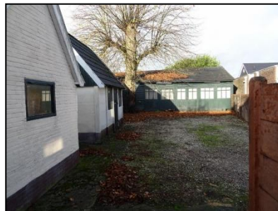
Figuur 4. Oprit en drie van de bijgebouwen gezien vanaf de achterzijde van de woningen.
