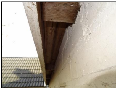
Figuur 13. Aftimmering aan de onderkant de betimmering, dit sluit de toegang tot de ruimte achter de betimmering af.
